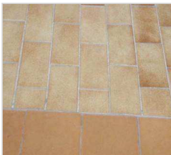
Slika 17: Podne obloge tepih (garderobe), keramičke pločice (hodnici, sanitarni prostori), kamen (hodnici i ulazi)
