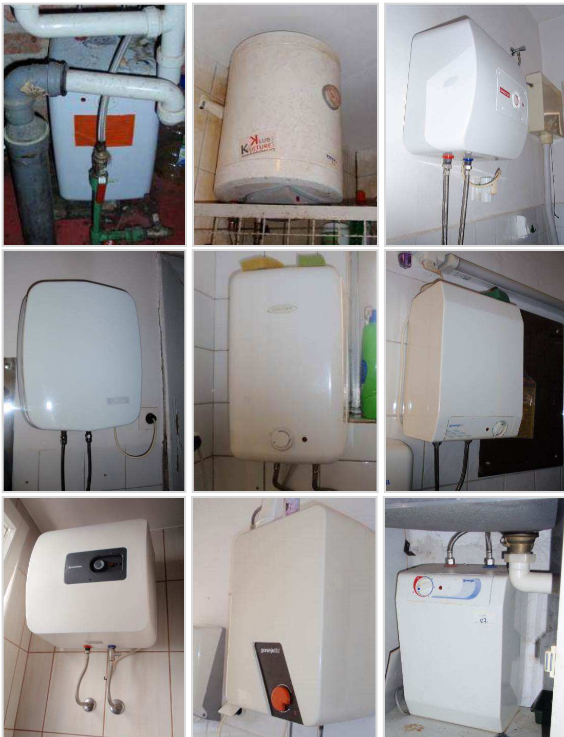
Slika 51: Električne grijalice vode
