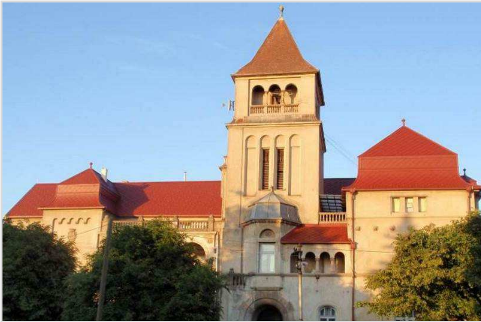
Slika 23: Pokrov pocinčanim bojanim limom i glinenim crijepom
