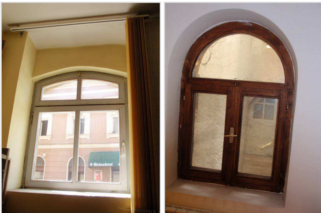
Slika 27: Drveni prozori krilo na krilo
