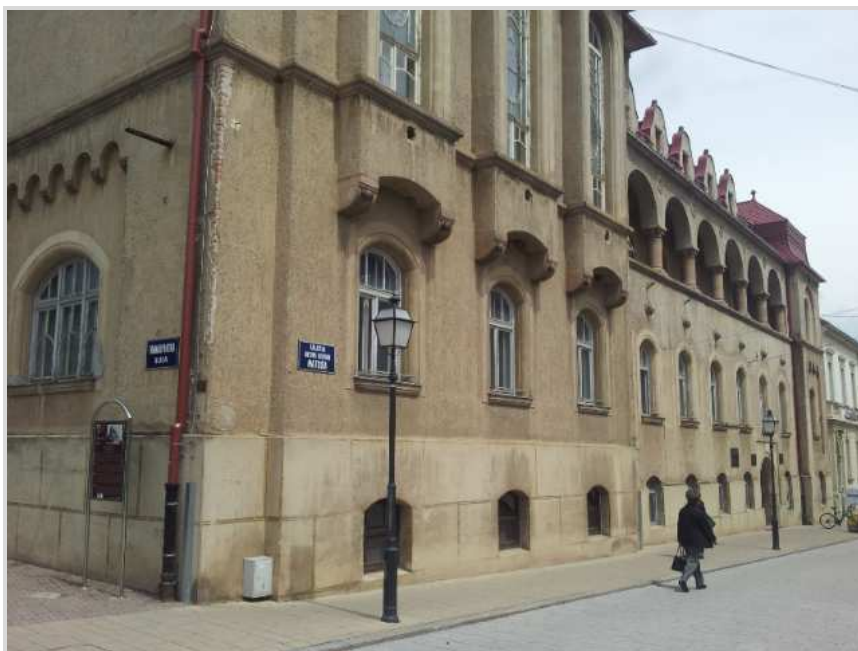
Slika 16: Zidovi podruma iznad zemlje obloženi kamenom
