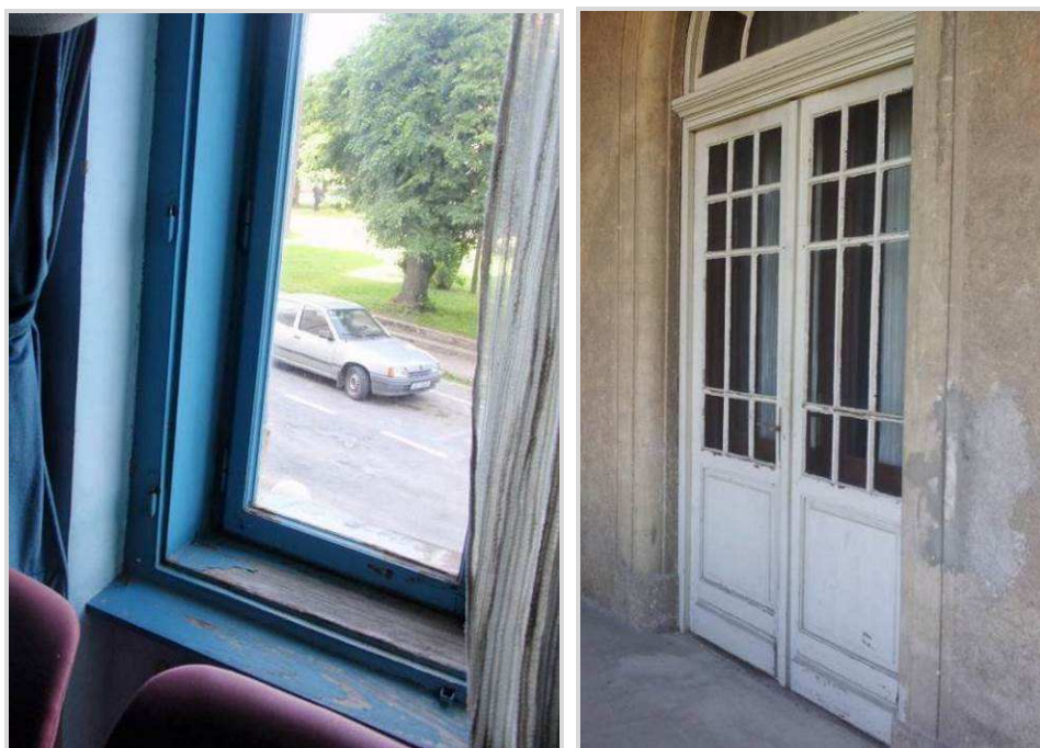
Slika 26: Drveni prozori i vrata sa dva doprozornika
