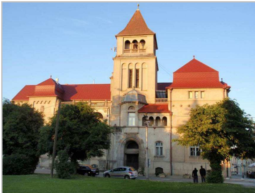
Slika 12: Hrvatski dom Križevci, zapadno pročelje
