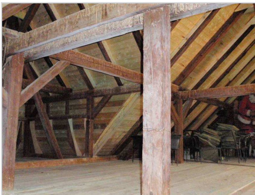
Slika 20: Pogled na krovnu konstrukciju s tavana
