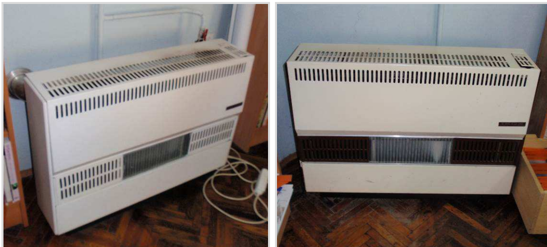
Slika 36: Plinske peći u uredima Velike dvorane
