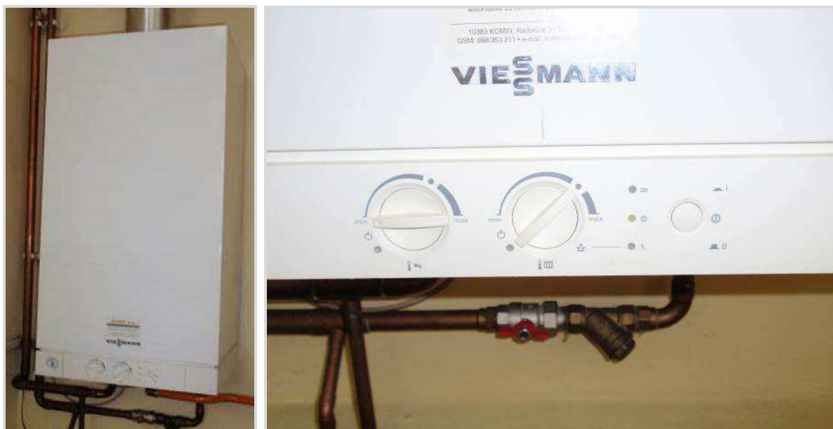
Slika 45: Plinski bojler u Gradskoj knjižnici
